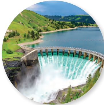
الشكل (9) بناء السدود
