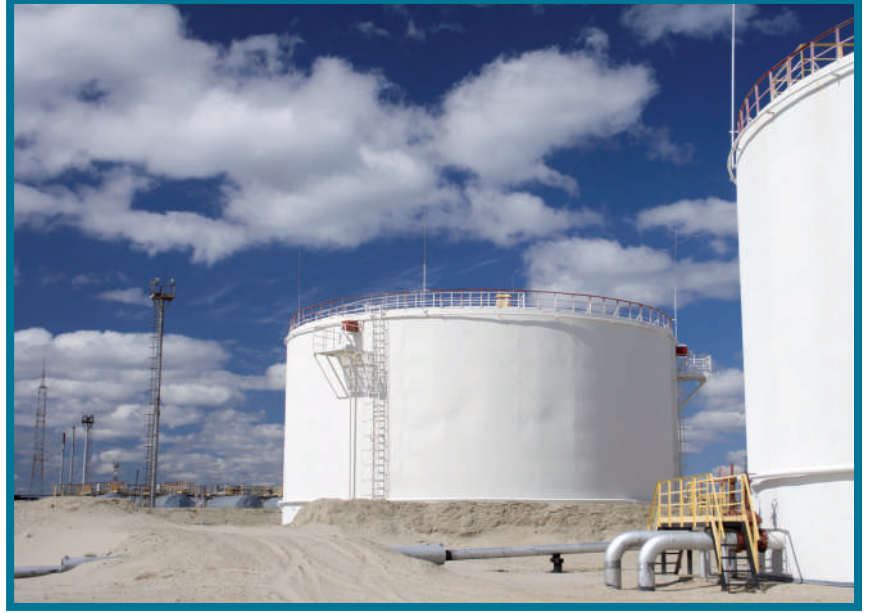
خزانات النفط في الكويت
