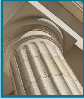
شكل 100 صخور كلسية تُستخدم في البناء.
